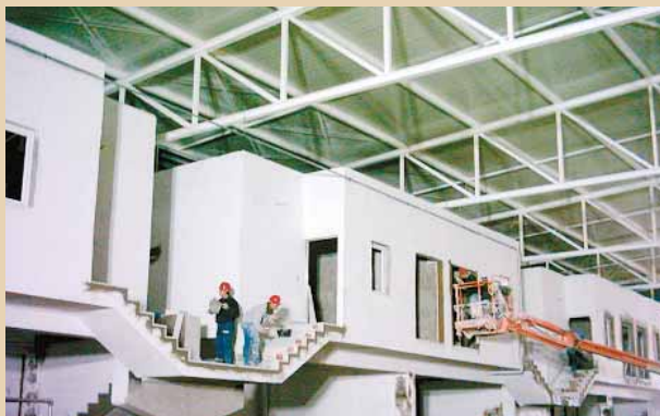
Preparación de los módulos del Mercado de Pescados de MERCALGECIRAS
