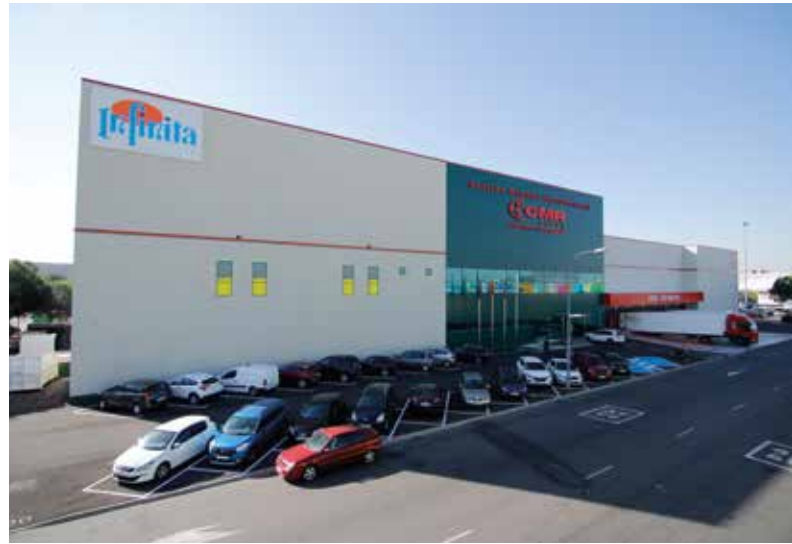
Nave de CMR en Mercamadrid. Foto facilitada por CMR
