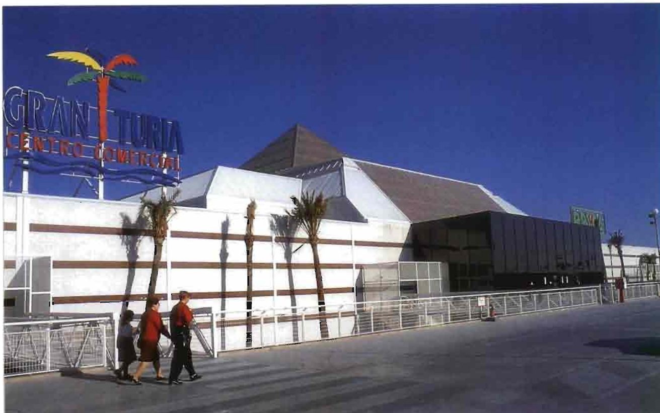
Todas las fotos que ilustran los trabajos sobre DISTRIBUCION EN LA COMUNIDAD VALENCIANA están realizadas en Valencia y Alicante.
