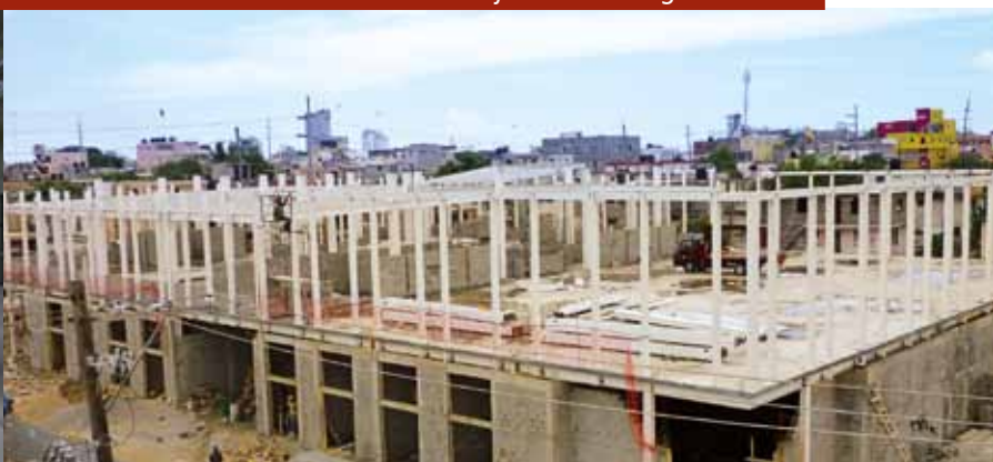
Obras del Mercado de Cristo Rey. Santo Domingo
