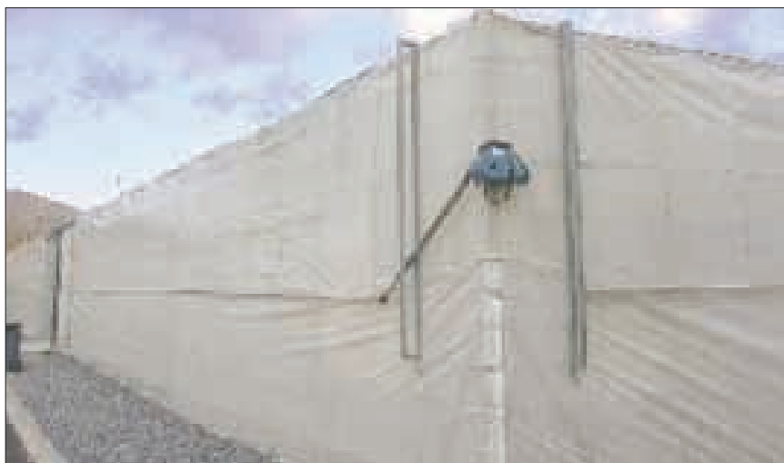
Invernadero “tipo Almería” – raspa y amagado.
