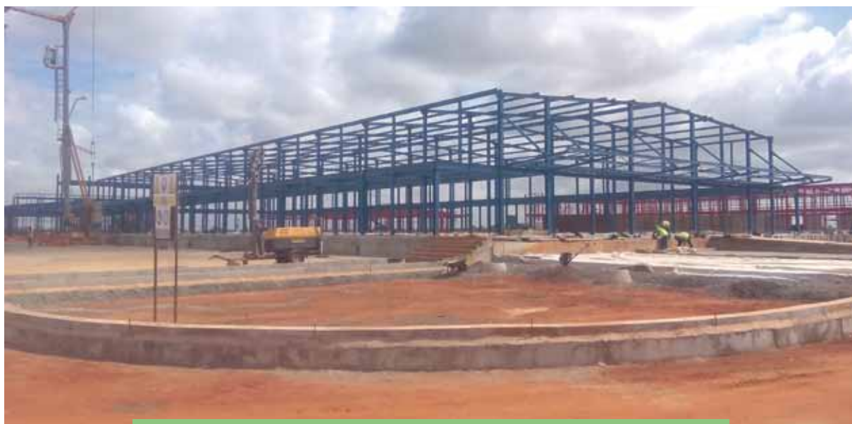
Obras en el CLOD Luanda (Angola)
