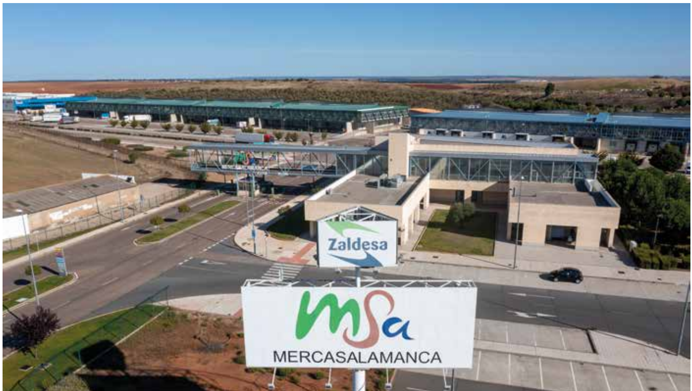
Nuevas instalaciones de Mercasalamanca en Zaldesa. (Fotografía: David Arranz)
