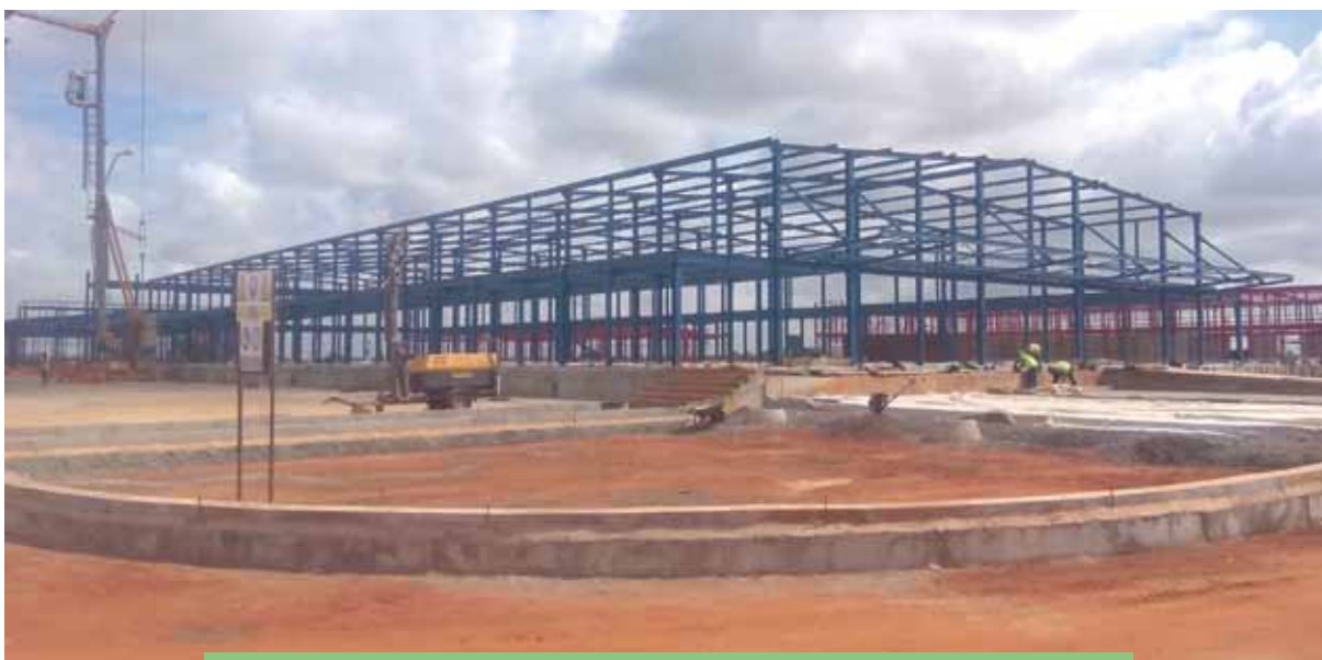
Obras en el CLOD Luanda (Angola)
