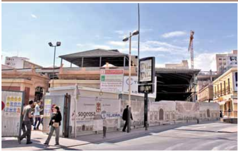
El Mercado Central de Almería en obras.
