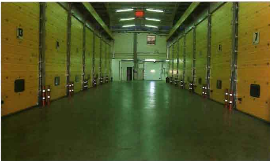
INTERIOR DE LAS CAMARAS DE MADURACION EN LA NUEVA NAVE DE PLATAMERCA.
