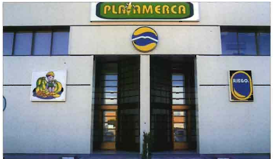
NUEVA NAVE DE MADURACION DE PLATANOS PLATAMERCA, LA MAS GRANDE DE ESPAÑA.
